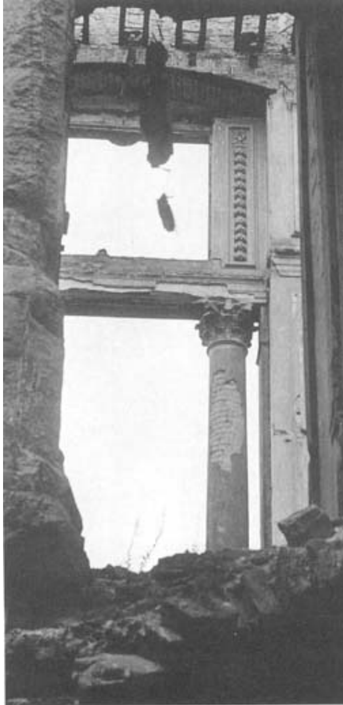
Abbildung 76: Großes Rampen- und Treppenhaus, Blick vom 2. Hauptgeschoss auf die Fassadenrückwand
