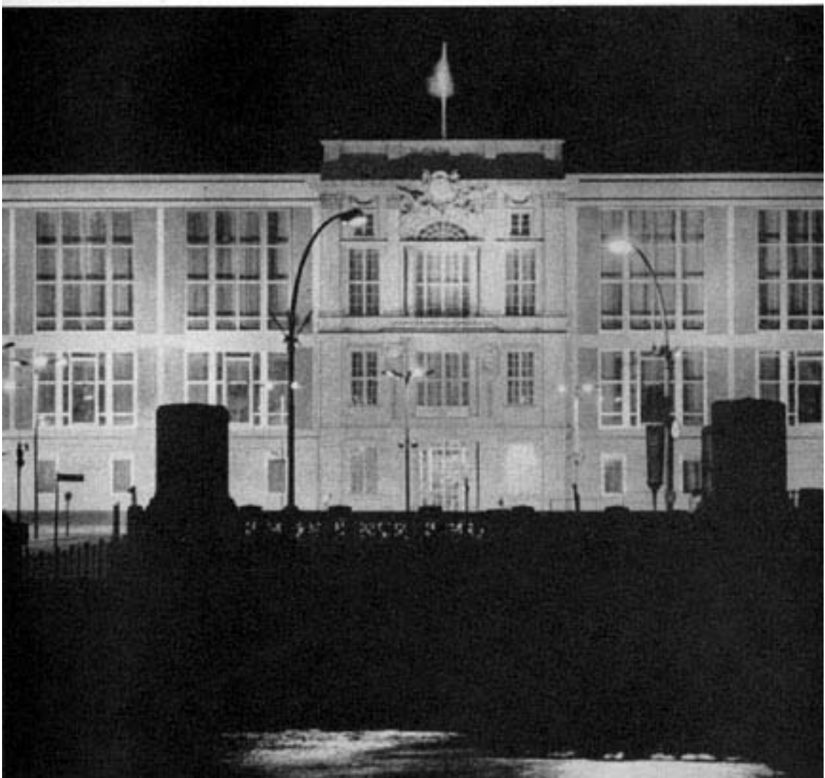
Abbildung 93: Das ehemalige Ministerratsgebäude (gegenwärtig Bundeskanzleramt) mit dem vorgeblendetem Portalrisalit IV der Lustgartenfront
