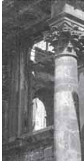
Abbildung 18a: Mittelfenster des 1. Hauptgeschosses im Großen Hofrisalit mit hinterlegter jonischer Säule (Ausschnitt aus Abb. 18)
