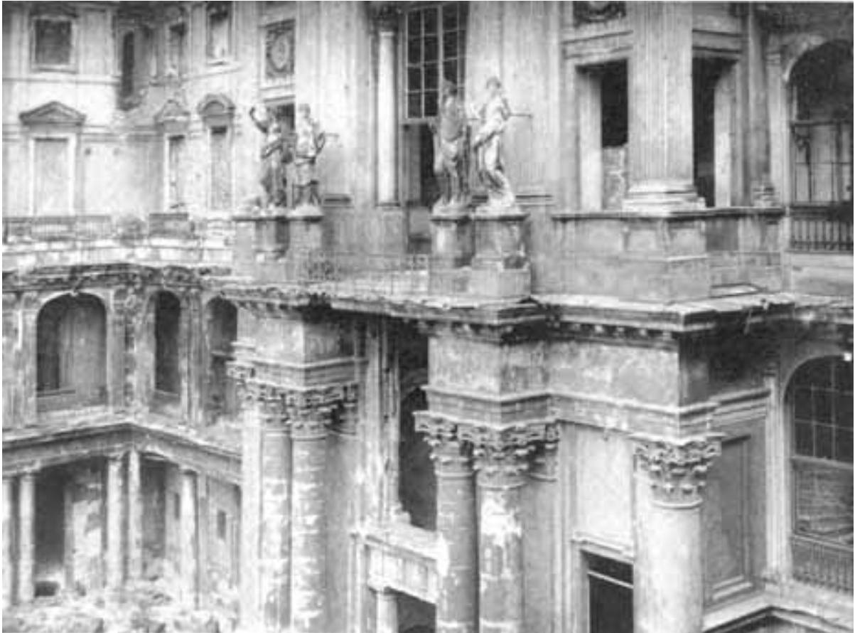
Abbildung 12: Seitlicher Hofrisalit am Lustgartenflügel, 1. Hauptgeschoss und Paradegeschoss (1950)
