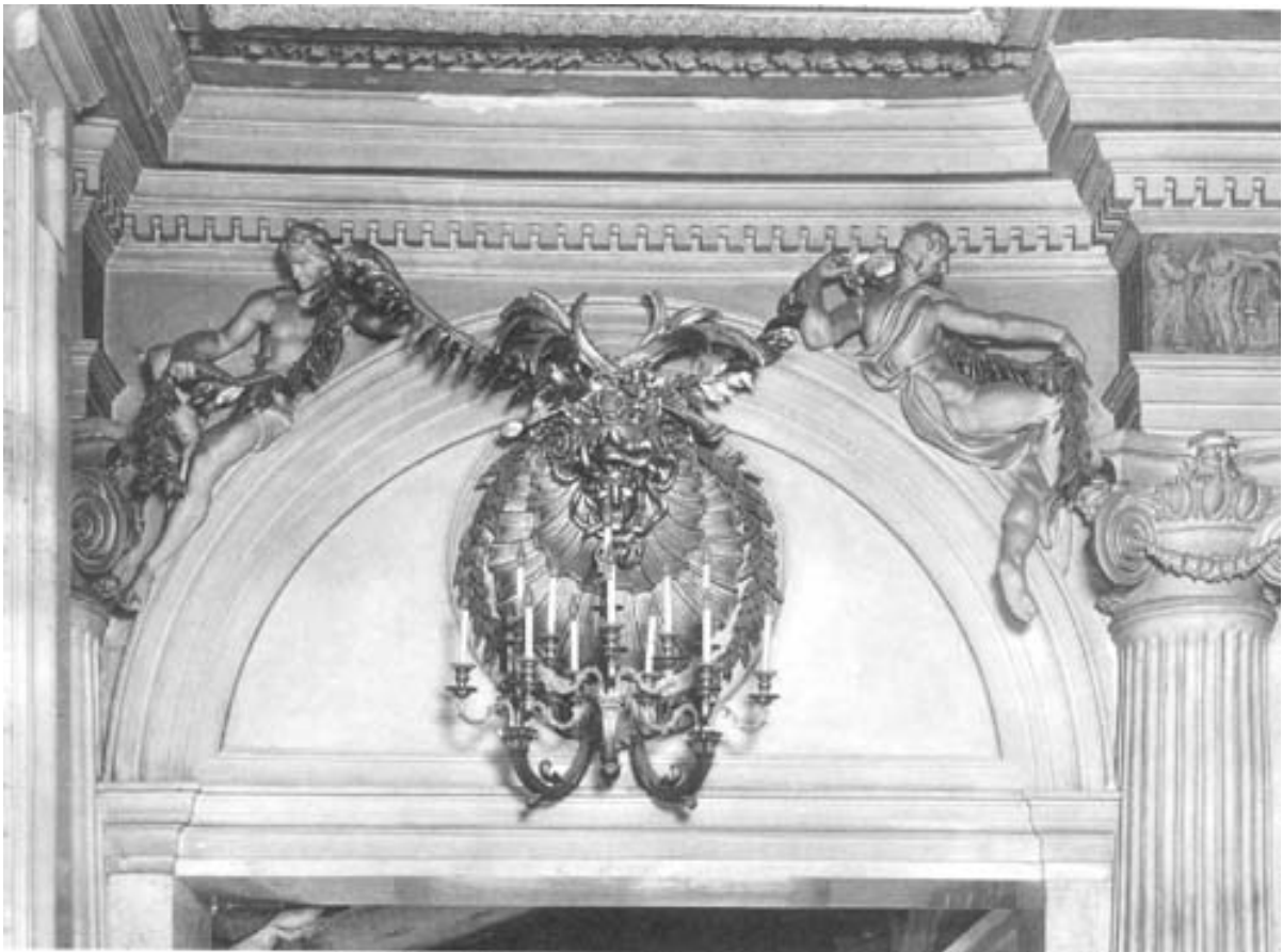
Abbildung 74: Großes Rampen- und Treppenhaus, Bogenfeld an der Galerie als Verblendung für die südlichen Treppe zum Schweizersaal
