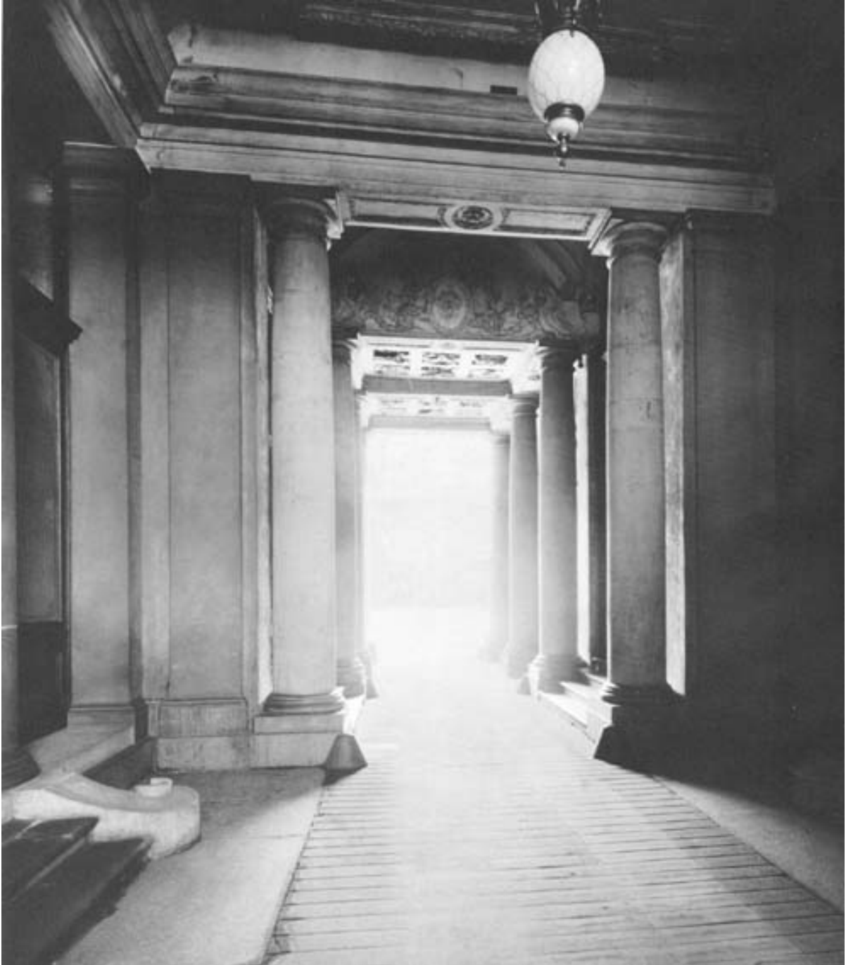
Abbildung 52: Blick durch die Halle des Gartenrisalits (ehem. Sala terrena) in die Hofeinfahrt
