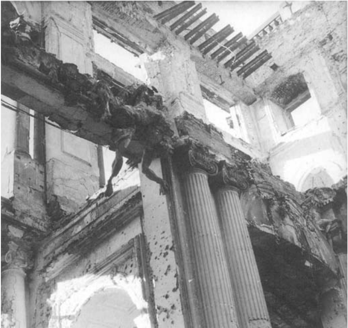
Abbildung 75: Großes Rampen- und Treppenhaus, Blick vom 1. Hauptgeschoss auf die Galerie und die Fassadenrückseite. Photo Kurt Reutti (1951)
